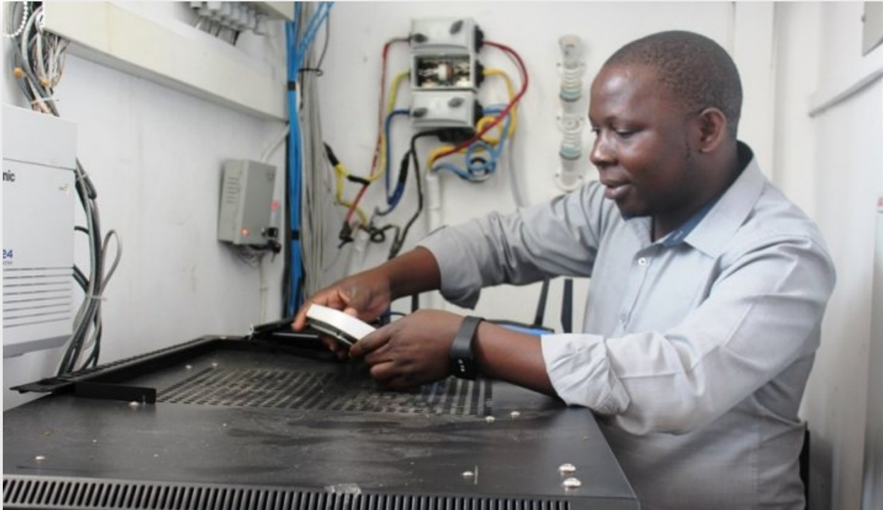
Meneja wa mifumo ya TEHAMA katika mradi wa PS3, Revocatus Mtesigwa, akikagua baadhi ya vifaa vilivyotumika katika ufungaji wa mtandao kiambo.
